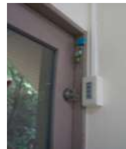
非常階段に続く防火扉に電気錠を設置
