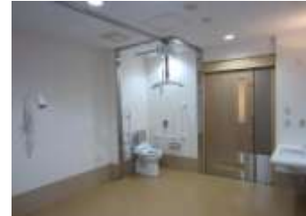
個室 2 室に天井走行リフト設置
