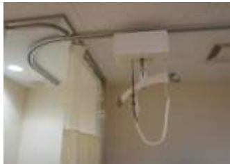
天井走行リフトでベッドからトイレまで
