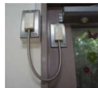
非常階段に続く防火扉に電気錠を設置
