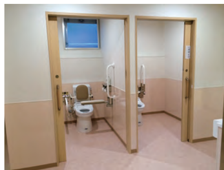
職員室前トイレ (改修後)
