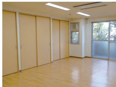
デイルーム (改修後)
