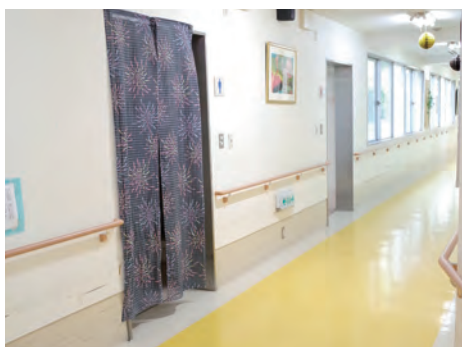
多目的室、旧共同トイレを廊下から
